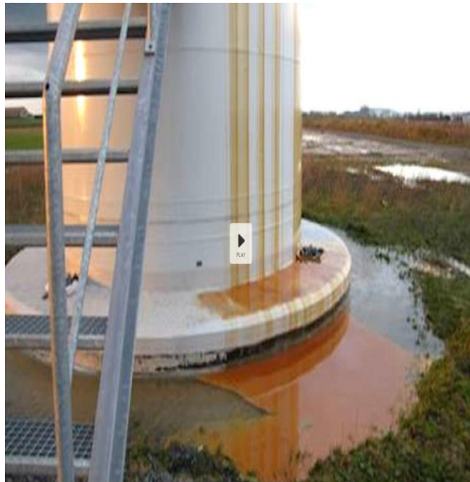
Figure 12 : Fuite d'huile depuis une nacelle sur une éolienne terrestre en 2012 à Leuze-Europe en Belgique.
