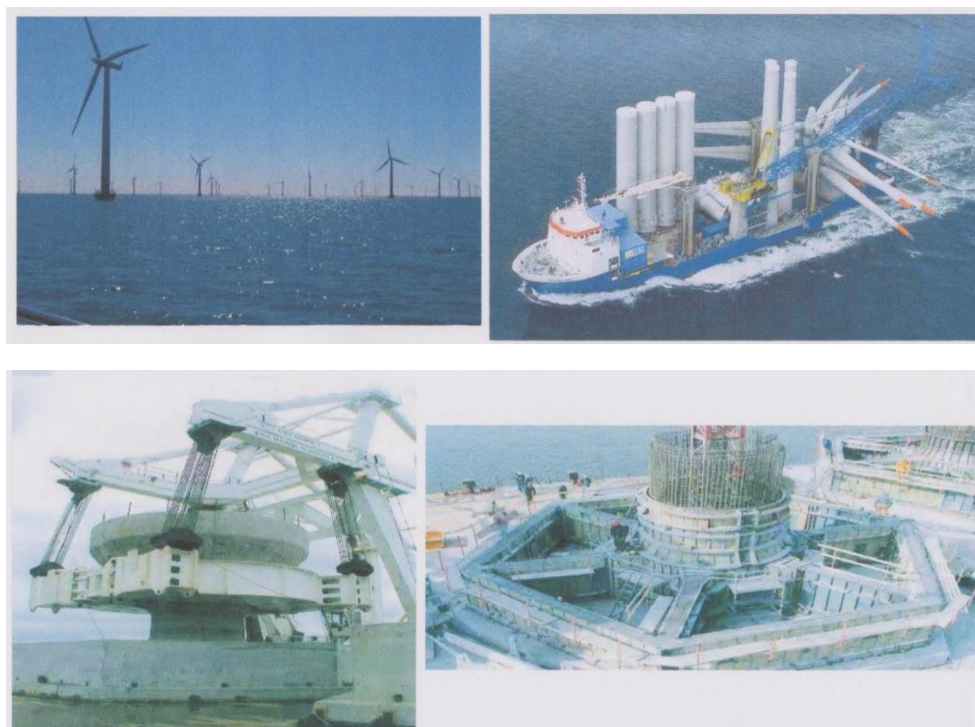
Figure 4 : L'implantation d'éoliennes en mer est une activité industrielle très lourde. En haut : à gauche, vue d'une centrale éolienne, à droite, barge de pose où on distingue les embases, les mâts et les rotors. En bas, création des fondations. Documents WPD.
