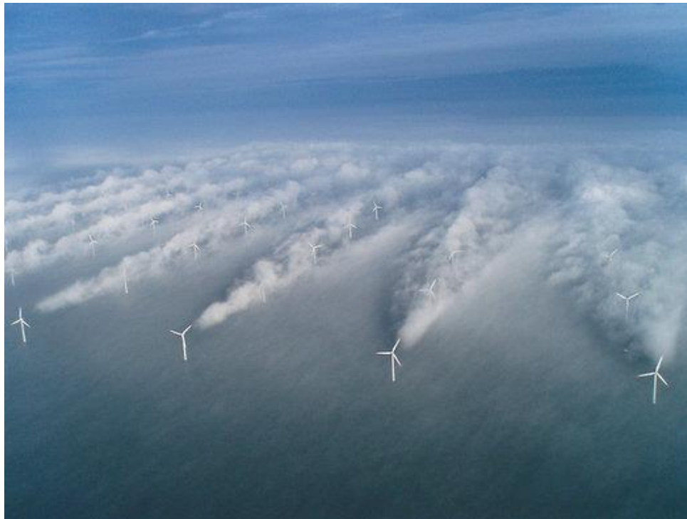
Figure 8 : traînées de la centrale danoise Horns Rev 1, montrant les turbulences derrière les éoliennes. Source : Vatenfall
