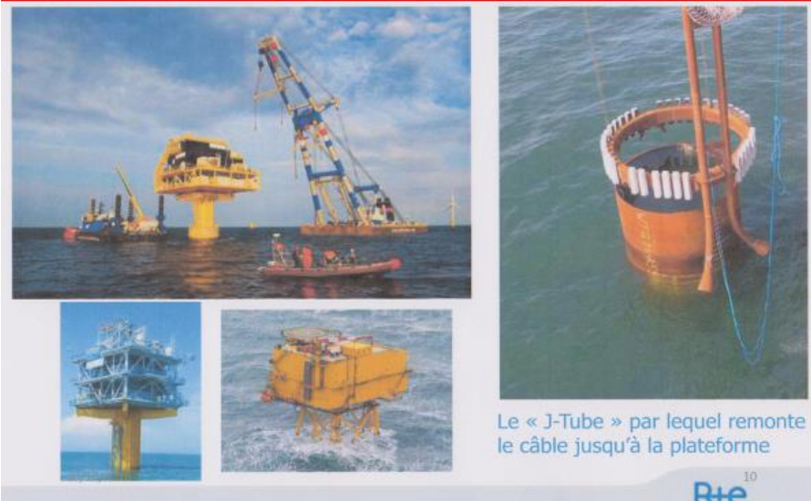
Figure 5 : construction de la plateforme du collecteur, équipée d'un hélicoptère, et installation du tube de passage du câble d'atterrissage.
